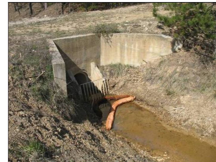
Exemple de « boudins » dédiés à l'absorption des hydrocarbures dans un cours d'eau
