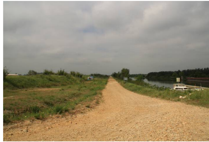
Les casiers au droit de l'écluse Saint-Gilles
