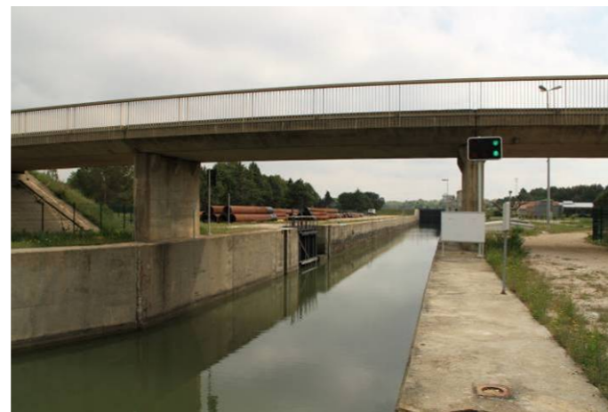
L'écluse de Saint-Gilles
